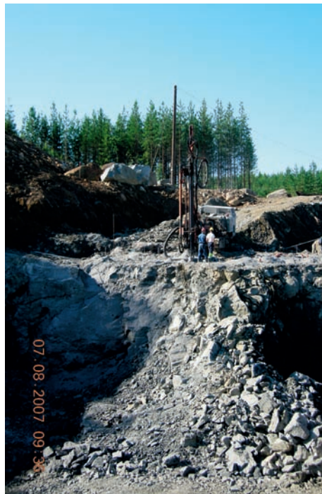
Kuva 1. Poraus avolouhintavaunulla.
